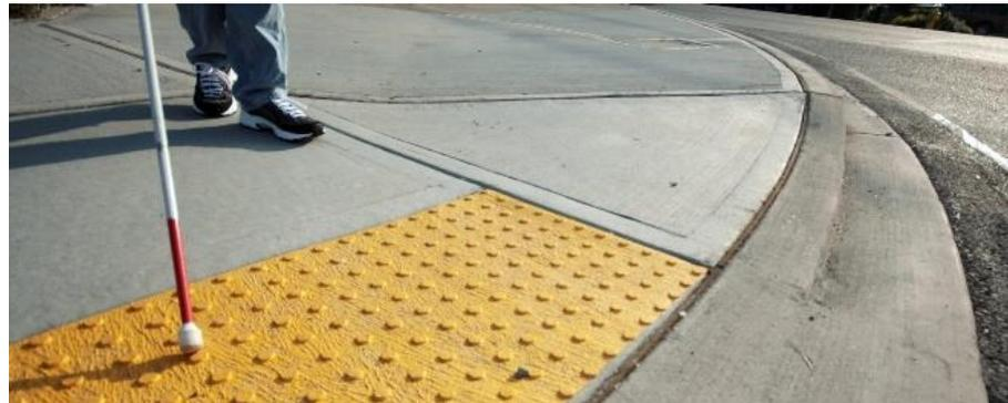
Устройство тактильной плитки
